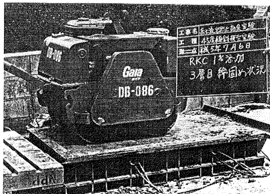
写真-2 締め固め状況
