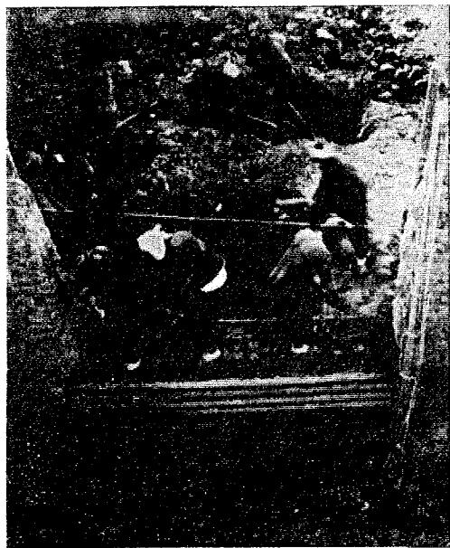
写真-1 住居土塹のための版築による施工状況
