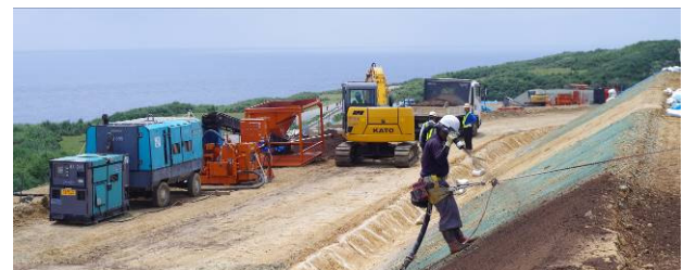
図 4 吹付状況 (分離型吹付プラント)
