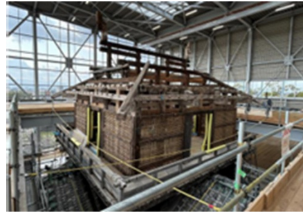
図-11 解体が進む宇土櫓五階部分
