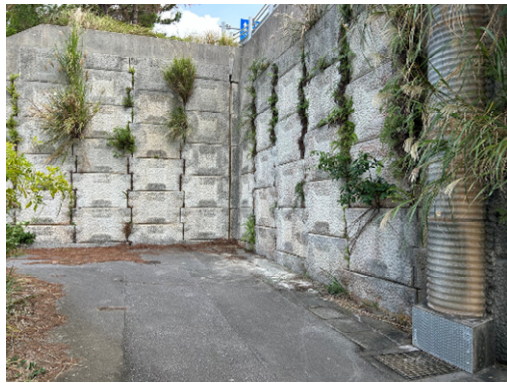
写真-1 対象補強土壁の外観(調査対象 C)
