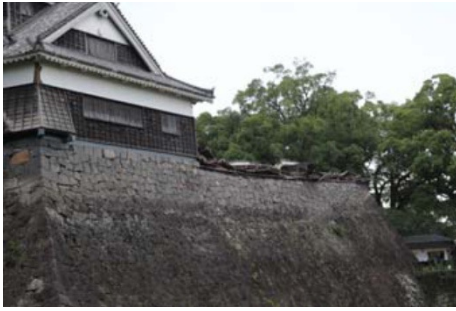
図-10 宇土櫓と結合された続櫓のみ倒壊 (加藤神社から大角恒雄 2016 年 7 月 19 日撮影)
