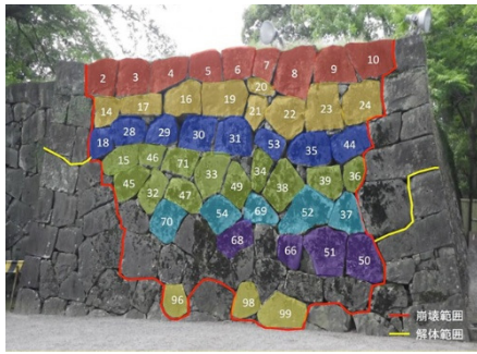
図-5 崩落前の加藤神社境内石垣（H99 面） 6)
