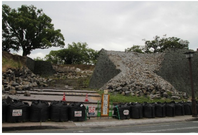
図-3 二の丸御門跡（右）と周辺の百間石垣（左）：平成熊本地震における被害状況（2017 年 6 月 19 日大角恒雄撮影）
