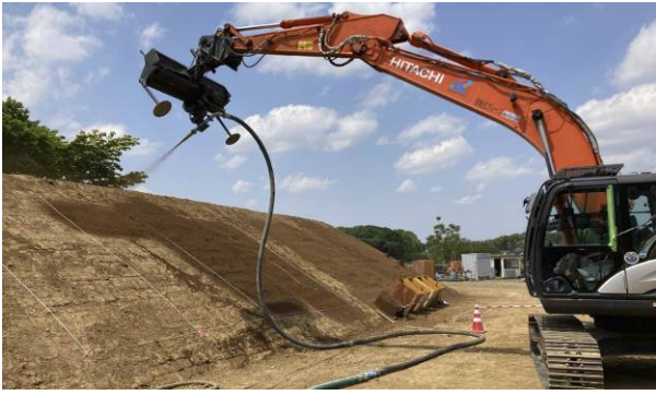
図 16 スロープセイバー吹付状況
