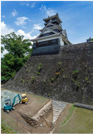
図-14 根石検出状況（宇土櫓南西側：熊本城調査研究センター 2022 年 6 月 23 日撮影）
