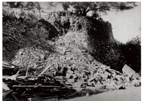
図-2 明治熊本地震で崩壊した旧熊本城飯田丸五階櫓石垣 3)
