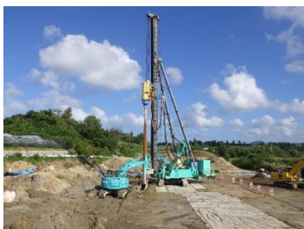
写真-8 金武工事におけるエポコラム Loto 施工状況
