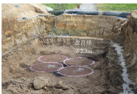
写真-9 エポコラム Loto 改良径 \phi 2.3\text{m} 確認状況
