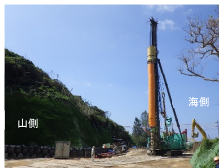
写真-4 数久田工事におけるエポコラム Loto 施工状況
