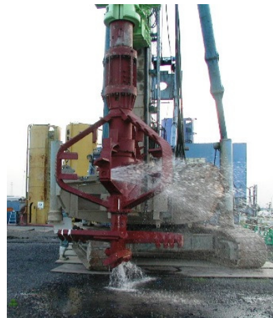
写真-1 エポコラム工法攪拌翼(翼径 \phi 2.3\text{m} 例)
