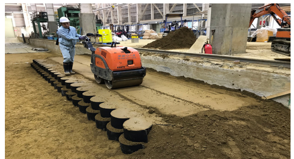
図 6 締固め状況(ハンドガイドローラー)
