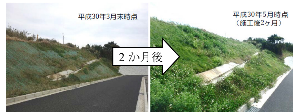
写真4 植生シート工補修工としての実施例(本島中部)
