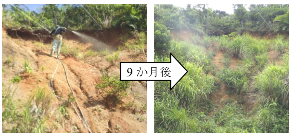
写真1 BSC工法施工状況例(石垣市崎枝)
