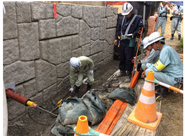
写真-1 現場引抜き試験の実施状況
