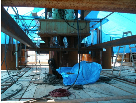
図-15 琉球石灰岩層に施工された杭基礎の原位置 載荷試験
