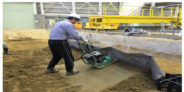
図 7 締固め状況(プレートコンパクタ)
