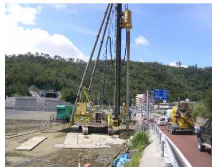
写真-5 世富慶工事におけるエポコラム Loto 施工状況
