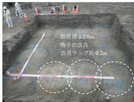
写真-7 世富慶工事のエポコラム Loto \phi 2.0m 改良出来形の確認状況
