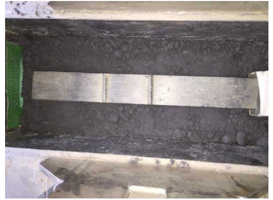
写真-3 補強材の設置状況 (頑丈土破碎材)
