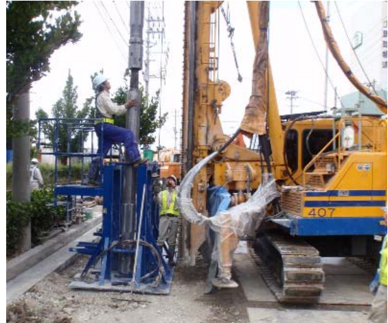
写真-3 軸受け台による施工
