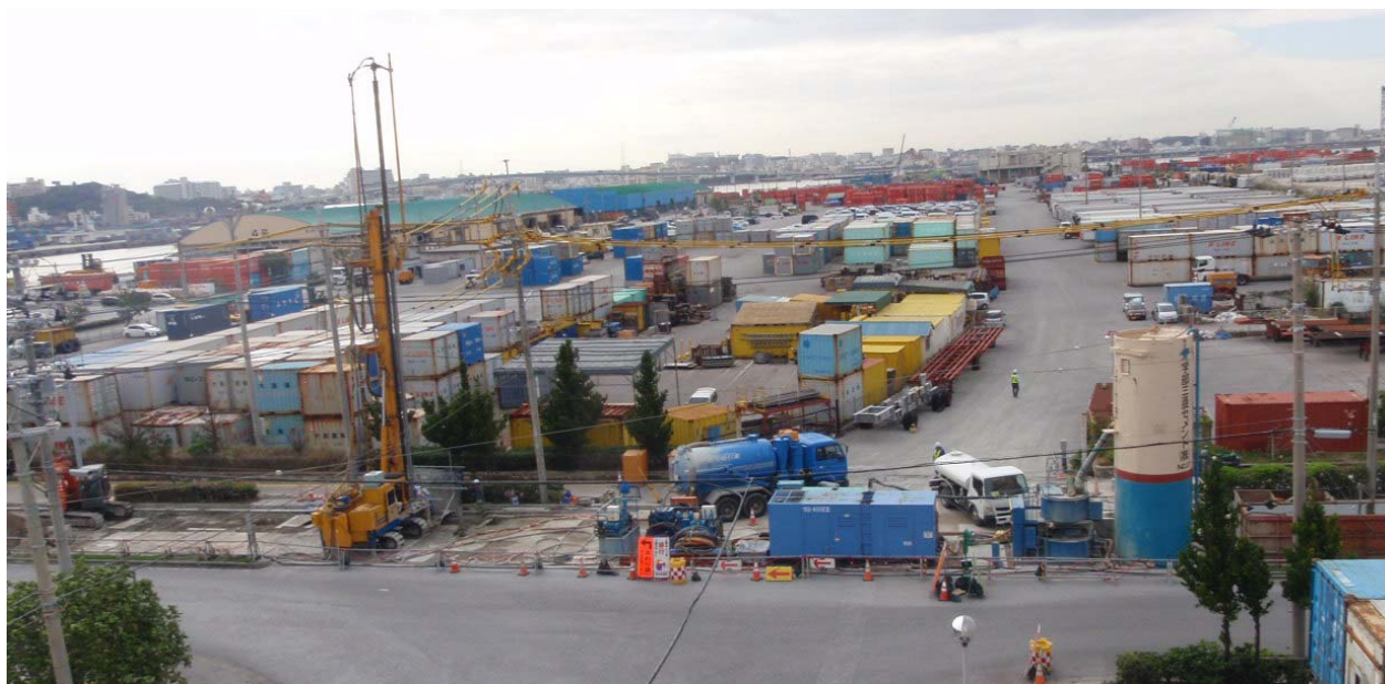
写真-5 FTJ工法の施工状況
