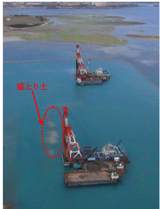
写真-1 SCPの施工状況
