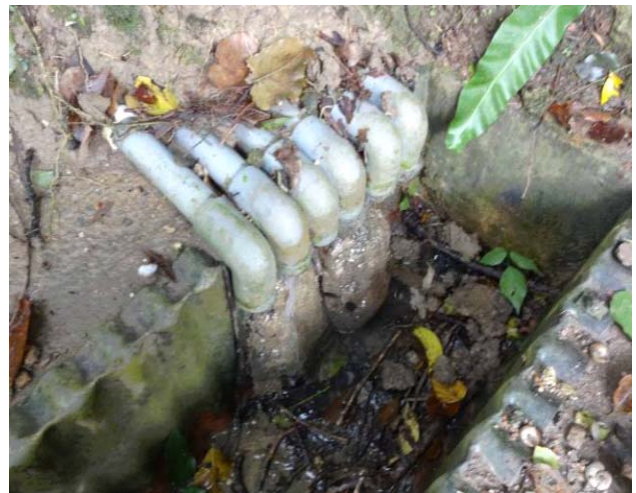
写真 2 山里地区の横ボーリング工 流末の破損、地下水の排水が認められない
