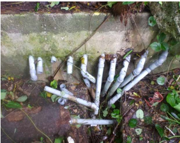
写真 2 山里地区の横ボーリング工 流末の破損、地下水の排水が認められない
