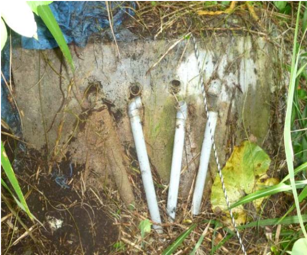
写真 1 仲順地区の横ボーリング工 流末の破損、地下水の排水が認められない
