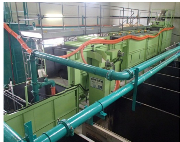
写真-10 稼働状況(NATMトンネル現場)
