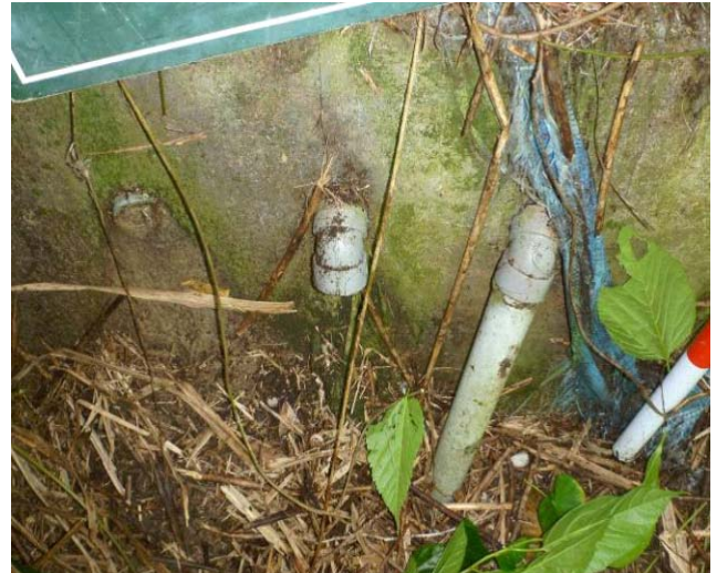
写真 1 仲順地区の横ボーリング工 流末の破損、地下水の排水が認められない
