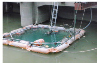
写真-13 潜水状況
