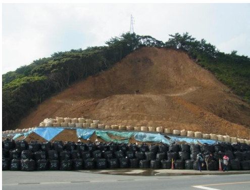
写真-1 浦地すべりの全景
