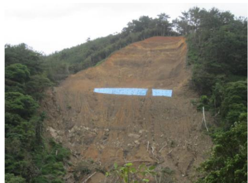
写真-4 秋名川崩壊の全景
