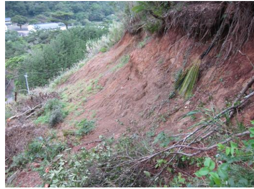
写真-6 芦花部地すべりの滑落崖
