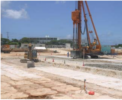
(a)改良地盤全景
