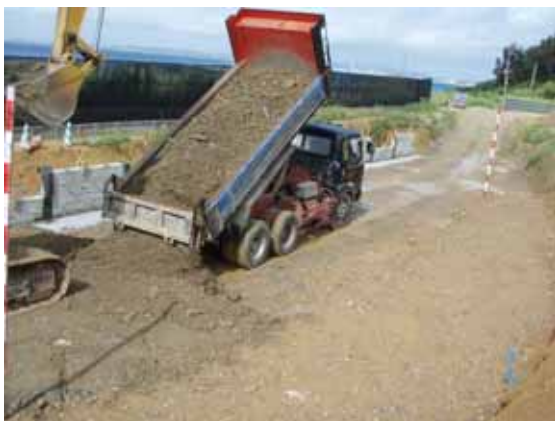
写真 - 2 【盛土施工状況】 (工区内切土部からの発生土を使用)
