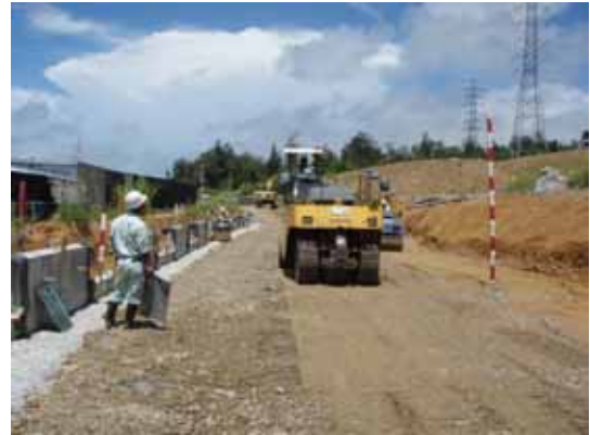
写真 - 3 【締めめ転圧状況】
