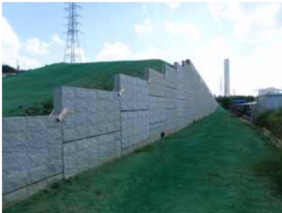
写真 - 1 【暫定施工分完了状況】 スーパーテールアルメ工法
