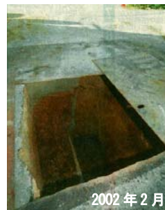
写真-4 道路陥没で現れた地下壕（那覇市） 1)
