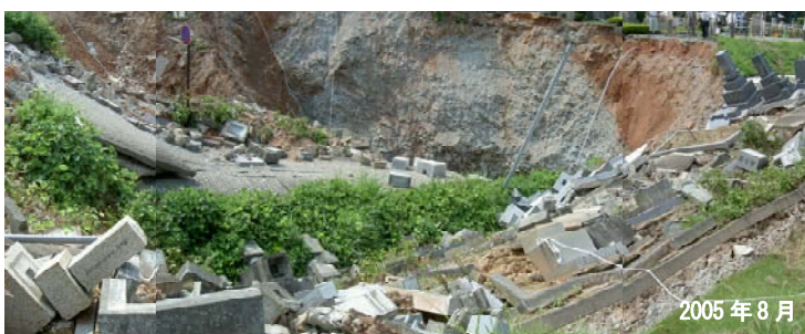
写真-3 地下採石場跡による陥没（福井市）
