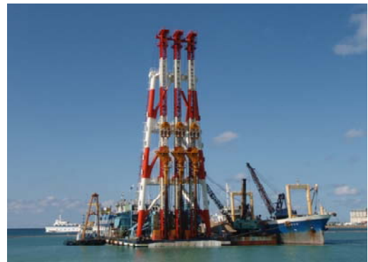
写真-1 施工状況(工事 No. 1)
