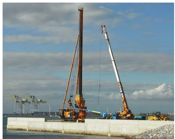
写真-2 施工状況（工事 No. ②）
