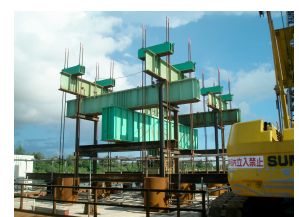
写真 3-1 押込み載荷試験の状況
