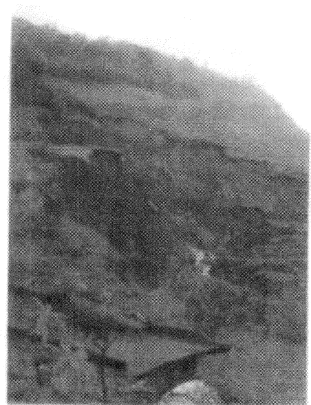
写真-4 中城村盛土斜面の地すべり
