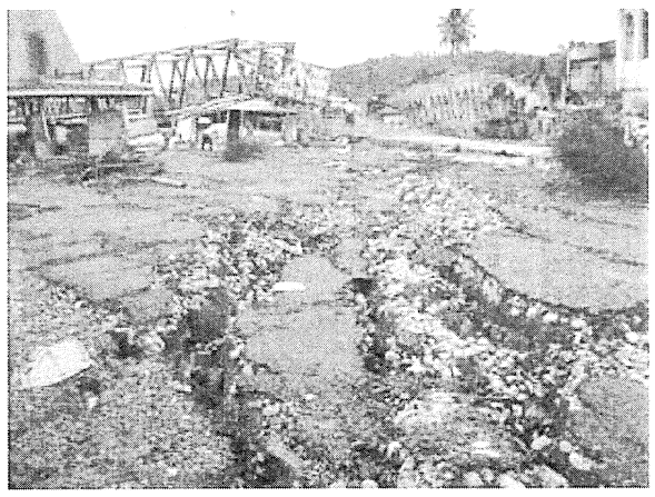
図-11：Gunung Sitoli 市における液状化による被害
