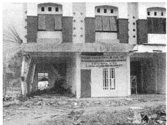
図-8 津波による RC 構造物の被害例
