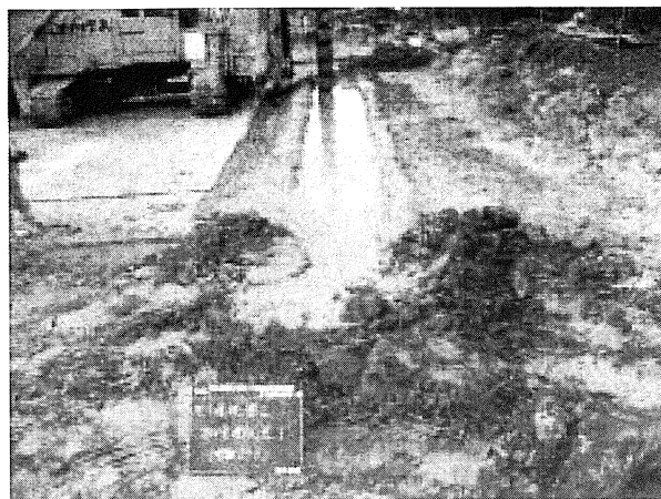
図-5 TRD 工 泥土発生状況
