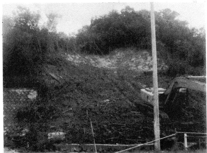
図-2 切土法面の崩壊状況
