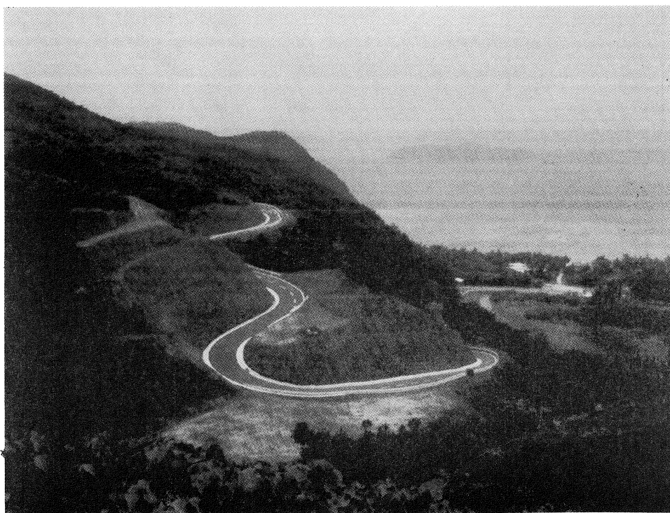
Ph.5 完成後の迂回路、のり面保護工とすべり止め舗装の様子
