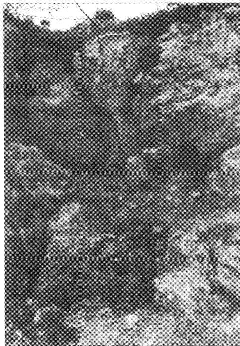
(d) 内部未固結型斜面、切土により岩質不良の石灰岩が露出した状況
