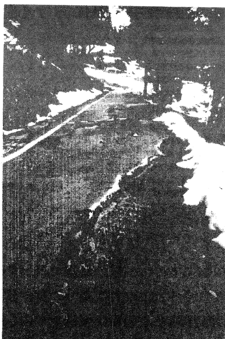
写真-2 平成 12 年の一次融雪期における 地すべり頭部の変状
