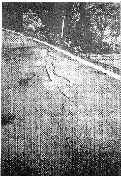
写真-1 平成 11 年の融雪期における 地すべり頭部の変状
