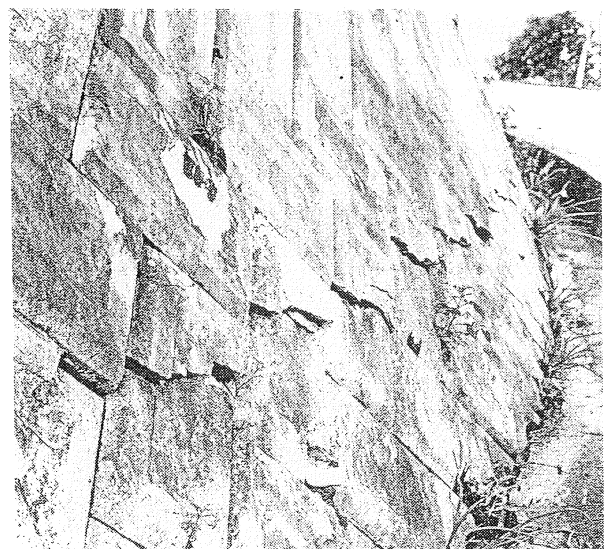
Ph. 3 崩壊跡地（右）、間知ブロック積み擁壁の亀裂（左）－Bブロック
